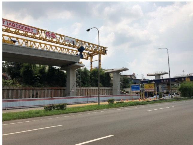
・資金繰りの悪化から一時中断されていた工事も再開された模様です。
