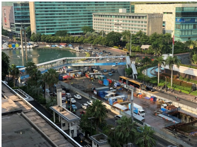
・市内中心部（タムリン噴水広場）でも着々と工事が進んでいます。
