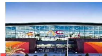
クレピエールが取得した「Nueva Condomina」
