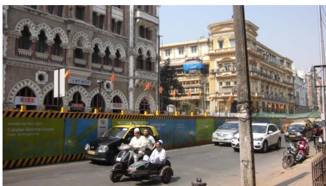
▲ムンバイの地下鉄建設現場。日本の JICA(国際協力機構)が有償資金協力を行っています。
