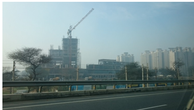
▲工業団地周辺では、高層住宅の建設が進んでいます。
