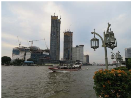
バンコク市内を流れるチャオプラヤ川沿いも建設ラッシュ。新しいコンドミニアムや商業施設が次々と誕生しています。
