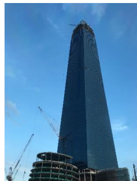
ペトロナスツインタワーの高さを上回る 超高層ビル「The Exchange 106」が建設中。
