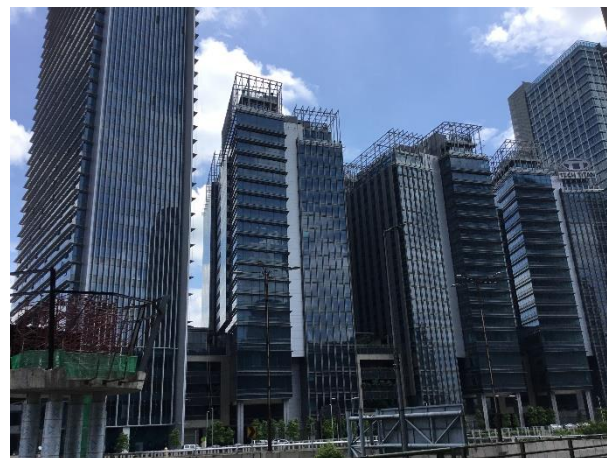
周辺のオフィスビル。左側に見えるのは、オフィスビルとショッピングセンターをつなぐ建設中の歩道橋です。
