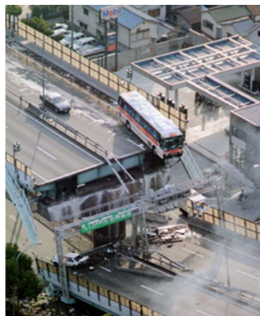
地震で崩壊した阪神高速道路と「落ちなかったバス」
